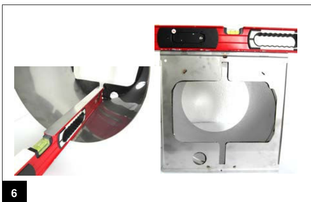
3.6 Muurhuls horizontaal uitlijnen.
